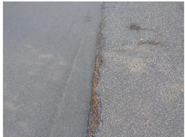
Abb. 25: Unsachgemäße Arbeitsfuge
